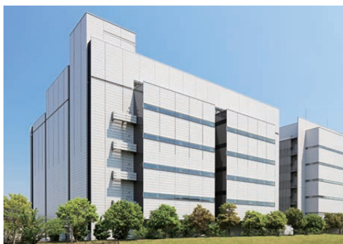
netXDC 千葉第3センター (S13)
