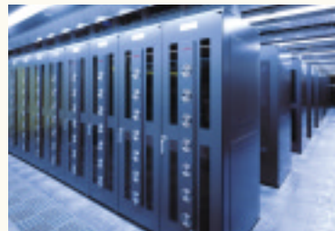
ビットアイルのiDC設備
