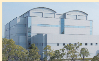
関西地区 eサービスデータセンター 「三田eDC」
