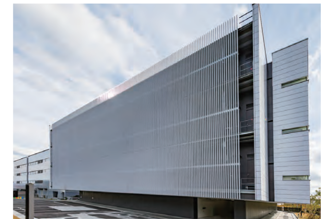
netXDC三田第2センター
